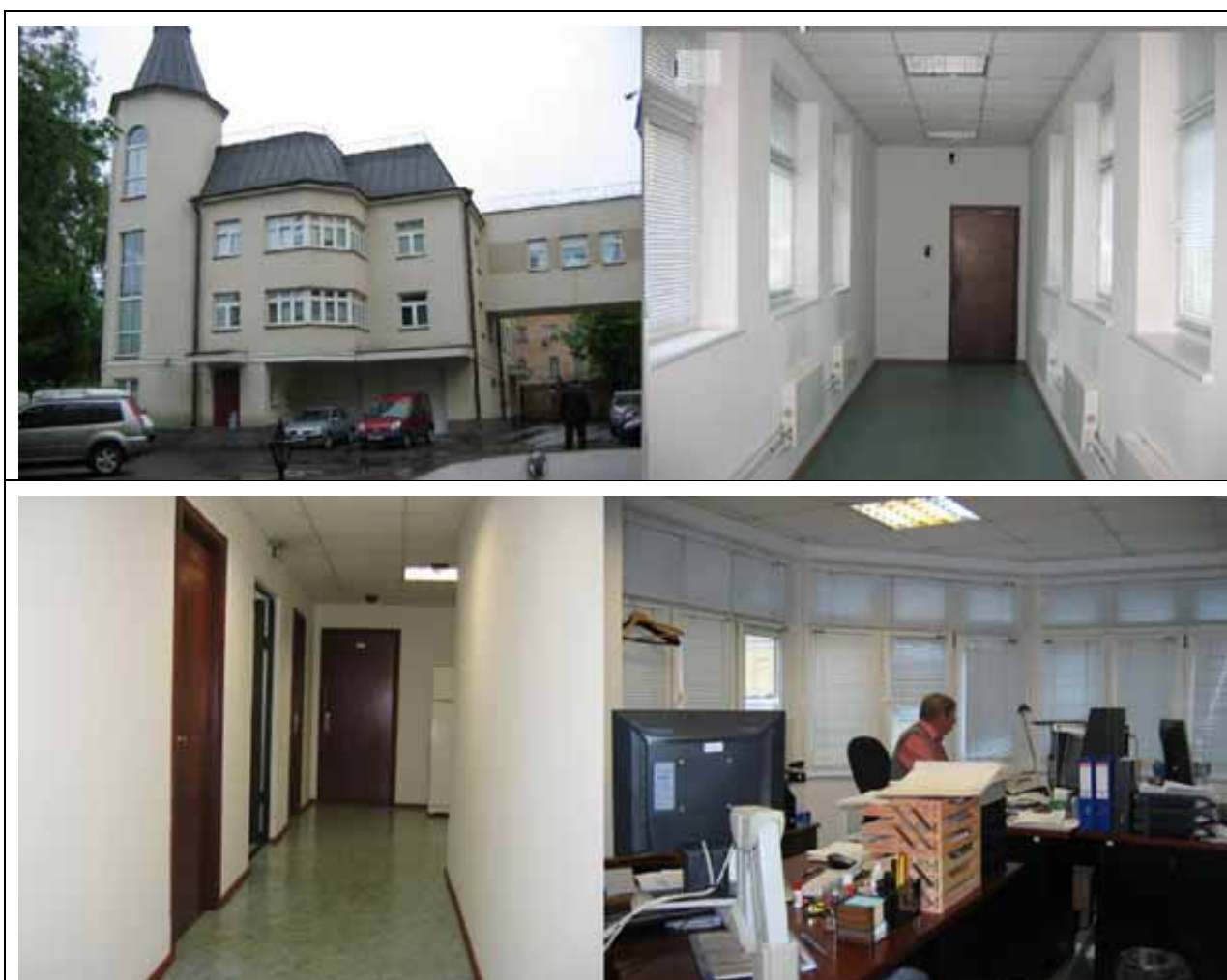
Рис. 15.3 Внешний вид здания ул. Погодинская, д.24, стр.2
